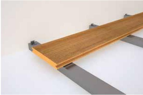
1. Applicare la clip di partenza ZCLE-F-PA avvitandola al magatello assicurandosi che le clip siano tutte allineate. Installare la prima doga inserendone il lembo inferiore nella cavità della clip.
