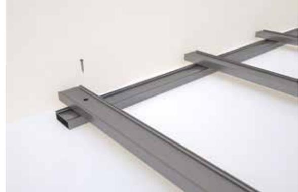
2. Nel caso di telaio sovrapposto eseguire dei fori  $\varnothing 5$  mm passanti sul magatello e allargarli a  $\varnothing 12$  mm in corrispondenza della superficie superiore. Eseguire quindi il fissaggio con vite auto perforante.
