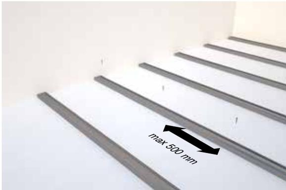
3. Fissare al fondo i magatelli mediante tasselli idonei, l'interasse dei fissaggi non deve superare i 500 mm.
