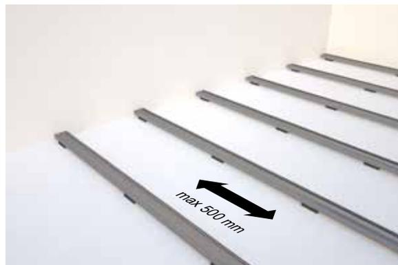
4. Qualora il fondo presenti delle irregolarità e sia pertanto necessario eseguire degli spessoramenti, è necessario garantire un appoggio dei magatelli in alluminio almeno ogni 500 mm.
