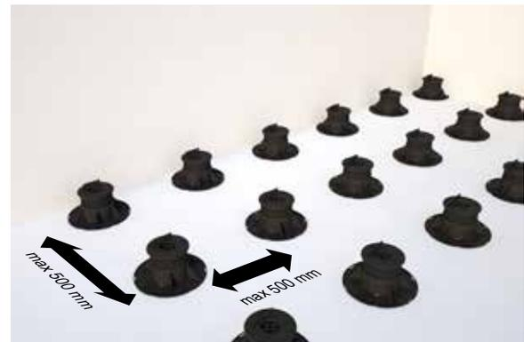
4. Nel caso di pavimentazione sopraelevata posizionare i supporti regolabili come indicato in figura.
