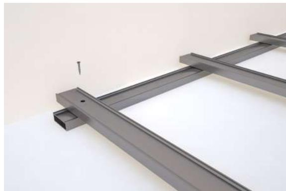
2. Nel caso di telaio sovrapposto eseguire dei fori  $\varnothing$  5 mm passanti sul magatello e allargarli a  $\varnothing$  12 mm in corrispondenza della superficie superiore. Eseguire quindi il fissaggio con vite auto perforante.
