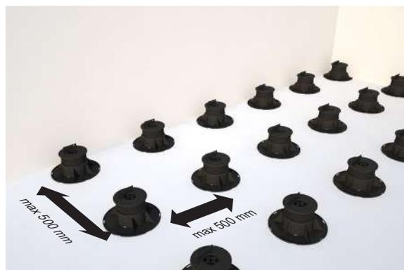
4. Nel caso di pavimentazione sopraelevata posizionare i supporti regolabili come indicato in figura
